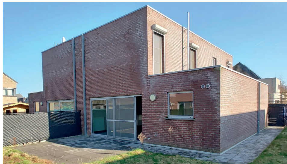
Opwijk, Millenniumstraat 70 (achterzijde)
